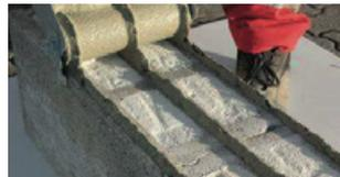
La hauteur minimale des cordons de colle doit être de **10 mm** => le mortier doit refluer à la pose du bloc supérieur
