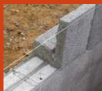
Encollage vertical des éléments
