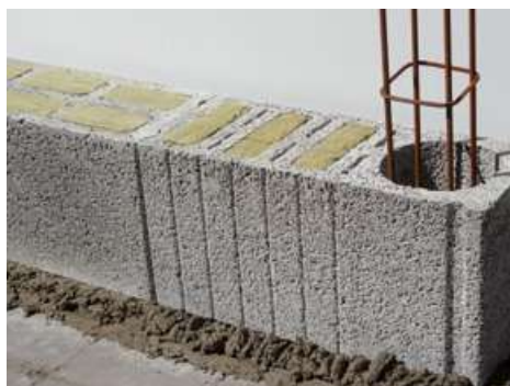
Renfort à l'aide d'une trame
