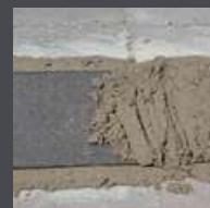
Pose d'un feutre bitumineux entre deux couches de mortier
