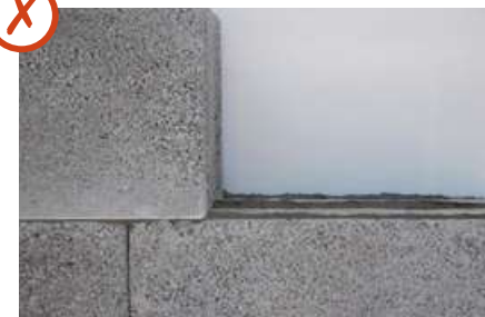
Appui inférieur à 1/3 de la longueur
