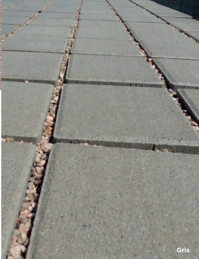
Grâce à ses écarteurs intégrés permettant de créer des joints larges (5, 15 ou 30 mm) entre pavés, l'Hydrojoint permet une infiltration rapide des eaux pluviales dans le sol. Facile d'entretien, la végétalisation des joints est possible dans la version Hydrojoint 30.
