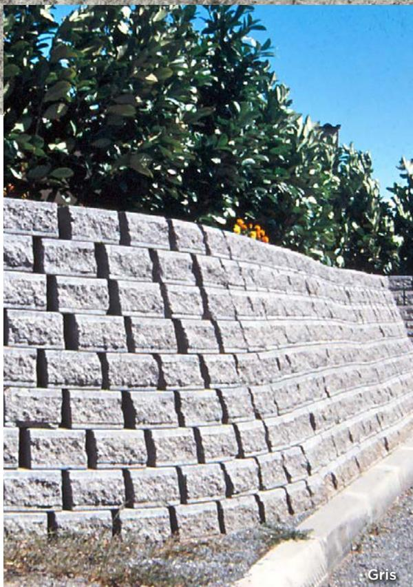
Le bloc Vauban est un produit économique et esthétique qui permet de réaliser des murs de soutènement. Il est réversible et peut laisser apparaître soit un côté lisse soit un côté béton éclaté en fonction des goûts de chacun.
