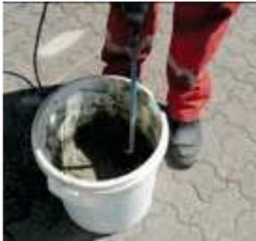
Mélangez un sac de **25 kg** de mortier joint avec la **quantité d'eau indiquée sur le sac**
