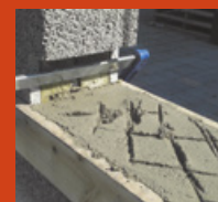
Lit de mortier coffré pour la pose de l'appui
