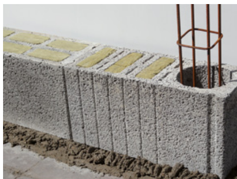
Renfort à l'aide d'une trame
