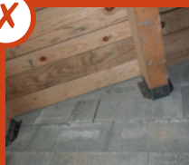
Les pannes de la charpente doivent être reprises dans les chaînages des rampants. En aucun cas dans les blocs béton standards.
