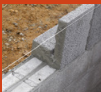
Encollage vertical des éléments
