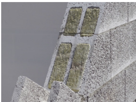
Découpe des blocs à la pente et arase du pignon avec U de chaînage
