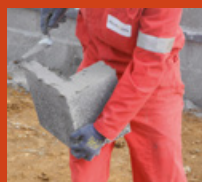
Encollage vertical des éléments
