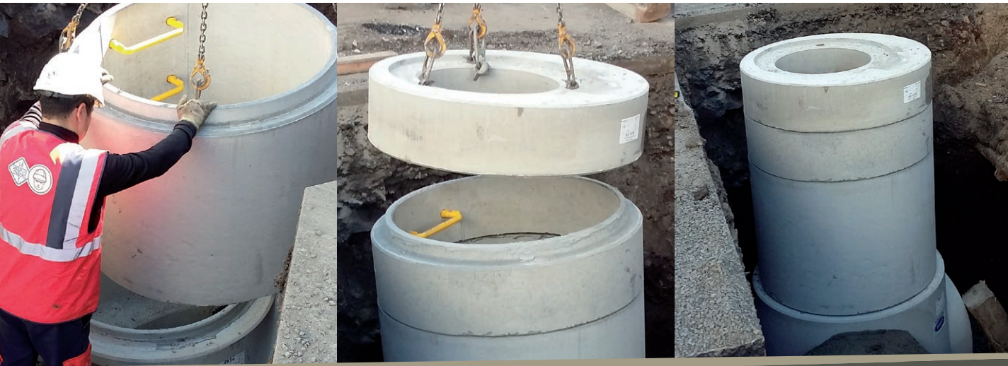
Manipuler les pièces à l'aide des ancres de levage prévus à cet effet
