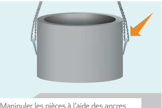
Manipuler les pièces à l'aide des ancres de levage prévus à cet effet
