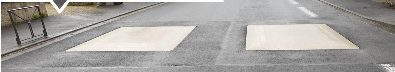
Le Coussin Berlinois Alkern est un ralentisseur destiné à modérer la vitesse des voitures, tout en permettant un confort de circulation aux cycles, aux véhicules de transport en commun et aux camions.
