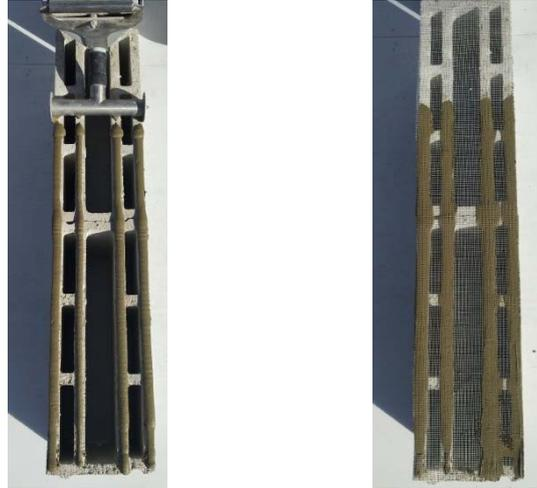
Figure 14 : Chaînage horizontal (détail des armatures)
