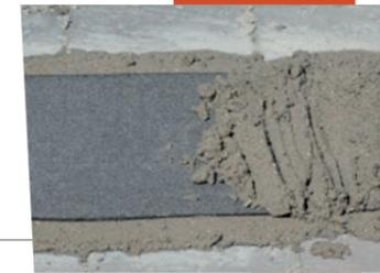
⚠ Pour éviter le glissement du mur (et sa fissuration), le feutre bitumeux ne doit pas être appliqué directement sur le plancher
